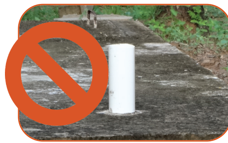
Cubra los tubos de ventilación.
